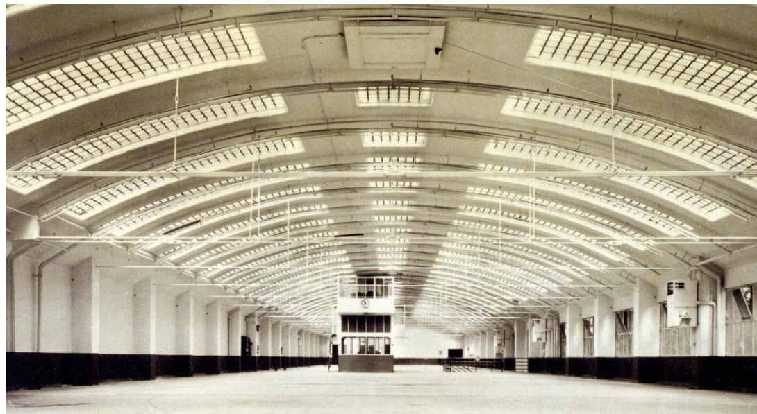
Bezugsfertige leere Halle auf dem neuen Werksgelände an der Leiersmühle.
